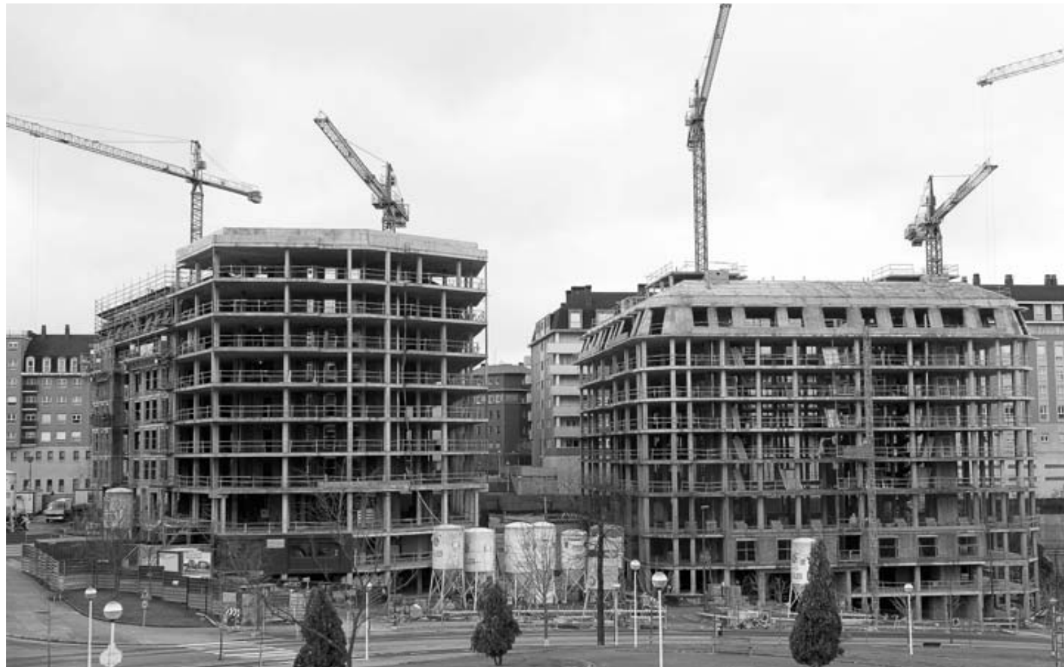
Dos bloques de pisos en construcción en Bilbao.
